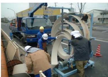
<写真3：マンホールから引込>
